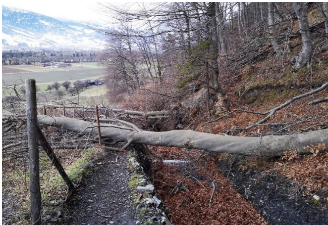
Abb.: Die Gerinne, wie hier im Bild die Rüfe Plandaditsch in Fläsch, müssen von umgefallenen Bäumen befreit werden damit keine Verklausungen entstehen.
